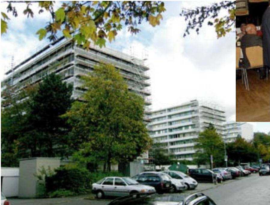
Die sanierten Häuser Watzmannstraße 10–17.
