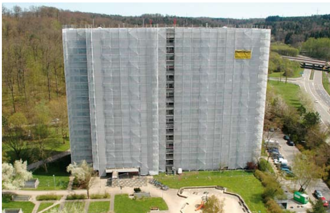
Erster Sanierungsabschnitt der Vieweide
