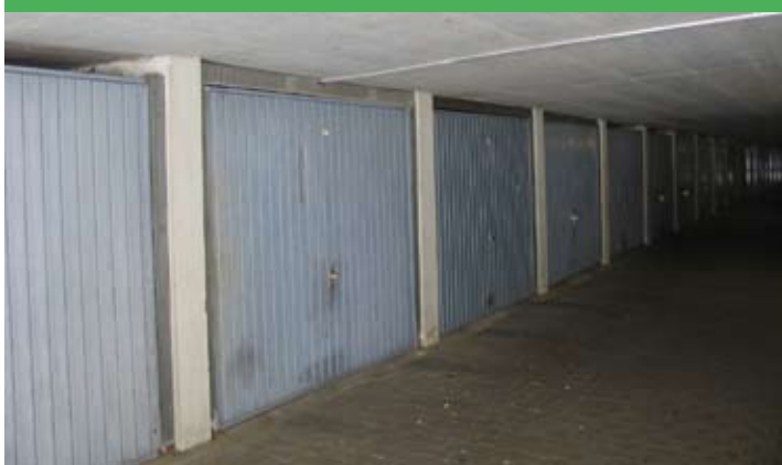
Tiefgarage vor der Sanierung
