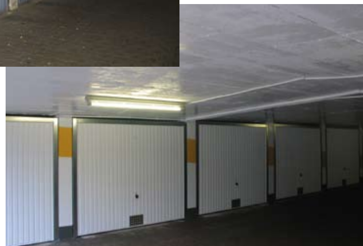
Tiefgarage nach der Sanierung
