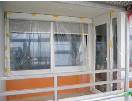
Die neue Fassade lässt sich bereits erahnen
