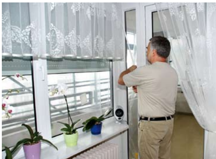
Neue Fenster mit Rollläden - Mieter in Aktion
