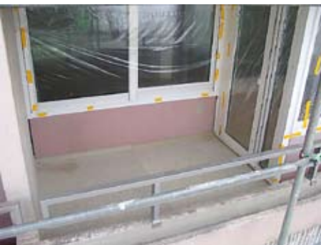
Neues Fenster mit Balkonfußbodenmuster
