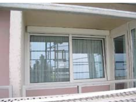
Neues Fenster - alte Fassade
