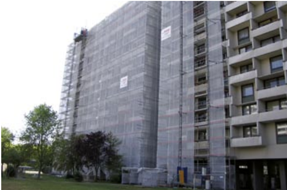
Rostocker Straße 50 und 52
