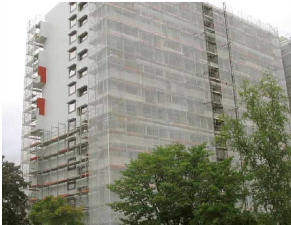
In der Rostocker Straße 51 und 53 in Stuttgart Bad-Cannstatt ist die neue Außengestaltung schon erkennbar.
