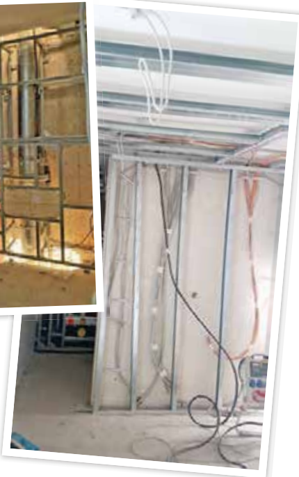
Neue Kabelstränge, ein GIS-Schacht und modernisierte Bäder sind Teil der laufenden Strangsanie rung.
