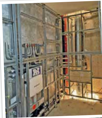
Neue Kabelstränge, ein GIS-Schacht und modernisierte Bäder sind Teil der laufenden Strangsanie rung.
